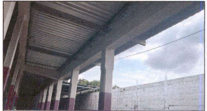
Foto 2: Techo terminado en corredor
