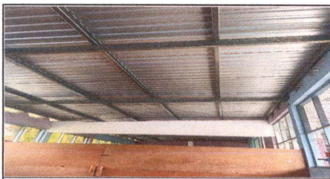
Foto 5: Techo colocado en área de aulas
