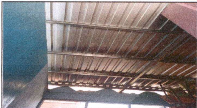
Foto 3: Techo colocado en aula
