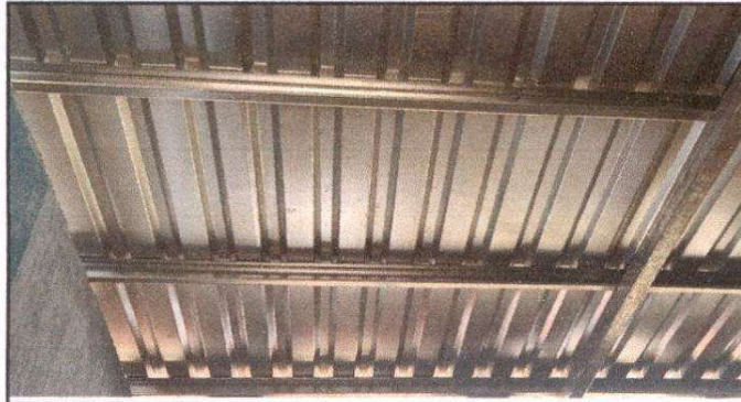
Foto 1: Techo terminado en aula
