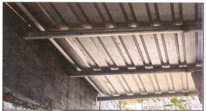
Foto 4: Estructura y techo terminados
