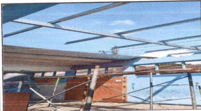
Foto 3: Trabajando estructura de techo
