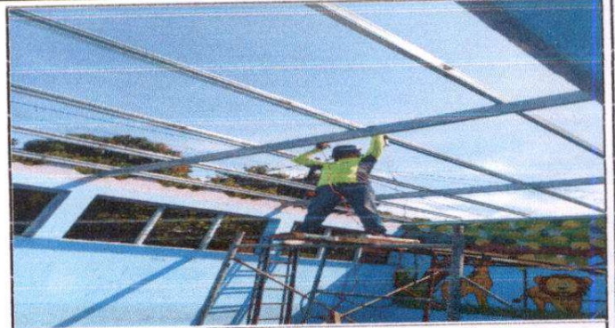
Foto 2: Colocando estructura para techo
