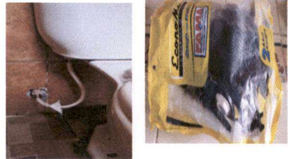
Foto 4: Instalacion de accesorios de inodoros (contra llave, tubo de abasto y tanque)
