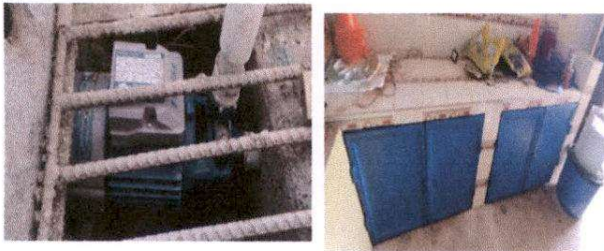
Foto 5: Instalacion de bomba de agua de pozo de 1/2 HP e instalacion de puertas pvc de cocina.
