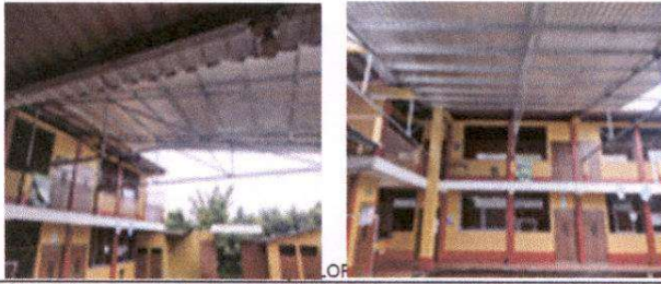
Foto 1: Instalacion de lámina, por lámina troquelada aluzinc calibre 26 de escenario e instalacion de estructura de soporte de metal por metal de escenario.
