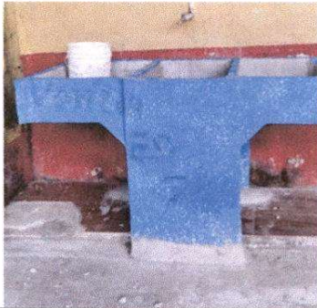
Foto 3: Instalacion de pila de cemento de dos lavaderos
