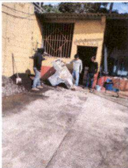
Foto 3: Desinstalacion de pila de cemento de dos lavaderos
