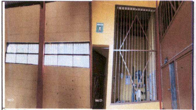
Foto 2: Suministro de ventanas pvc de aulas y dirección.
