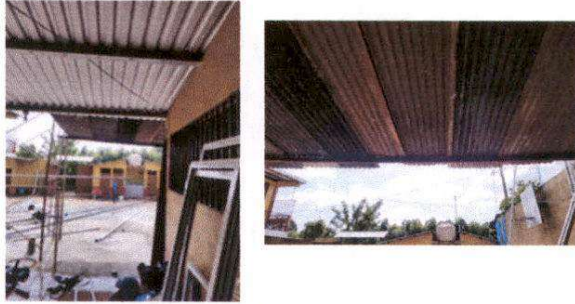
Foto 1: Sustitución de lámina, por lámina troquelada aluzinc calibre 26 de escenario y Sustitución de estructura de soporte de metal por metal de escenario.
