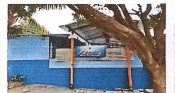
Foto 6: Pintura de paredes interior y exterior
