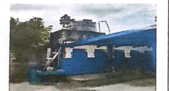
Foto 5: Sustitución de depósito de agua de 1700 lt.
