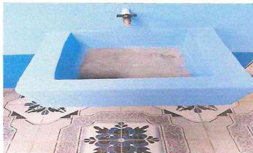
Foto17 : Construcción de lavamanos en el área de cocina.
