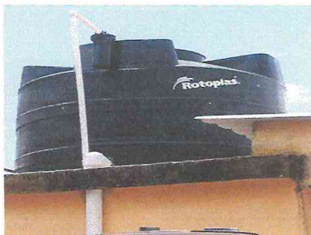
Foto 9: Sustitución de depósito de agua por uno de 1700 litros (Incluye accesorios).
