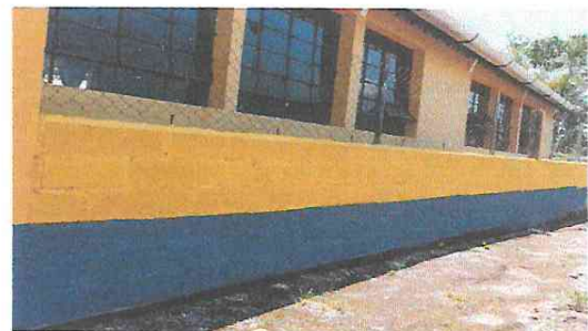
Foto 18: Levantado de muro perimetral
