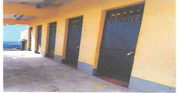
Foto 14: Mantenimiento de puertas, (lijado, cepillado aplicación de pintura).
