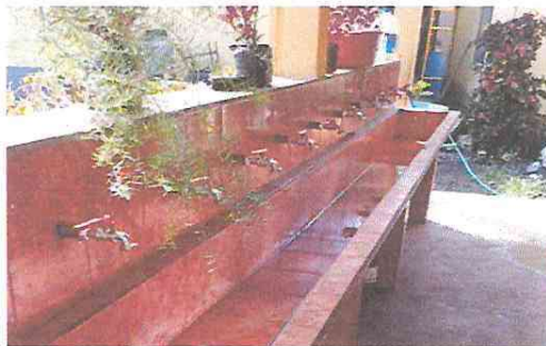
Foto 8: Sustitución de chorros.
