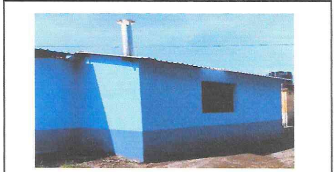
Foto 2: Cerramiento en muro con levantado de block y en cocina.
