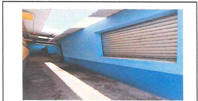
Foto 4: Pintura en muros exteriores e interiores en cocina.
