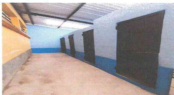
Foto 11: Cerramiento de muro con levantado de block en muro perimetral adjunto al servicio sanitario y Mantenimiento a puertas 0.75 x 1.80 M (Lijado, cepillado, aplicación de pintura). Pintura de interiores y exteriores de muro perimetral y baños.
