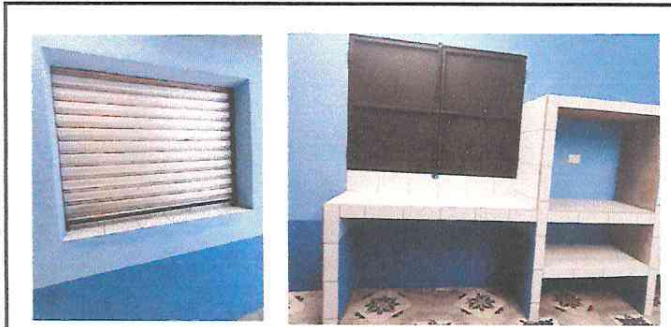
Foto 3: Sustrucción de ventanas de madera por metal.
