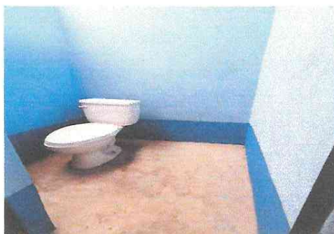
Foto 12: Sustitución de migitorio, sustitución de accesorios de inodoro (Contrallave, manguera de abasto, y accesorios de tanque, sustitución de tapaderas, sustitución de mezcladora para ducha).
