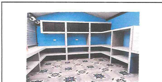
Foto 5: Sustrucción de piso de concreto alisado por piso cerámico e instalación de azulejo en muebles de cocina.
