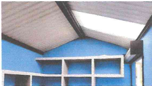
Foto 7: Mantenimiento a estructura de soporte de metal de la cocina ( Lijado y pintura de costaneras y láminas),
