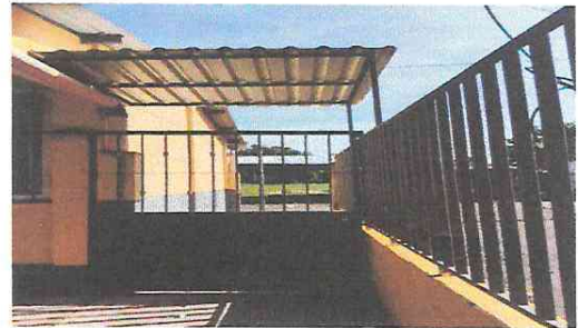
Foto 16: Sustitución de puerta (reja) por puerta con lámina lisa.
