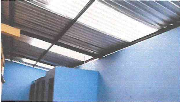
Foto13: Sustitución de lamina por lámina troquelada calibre 26.
