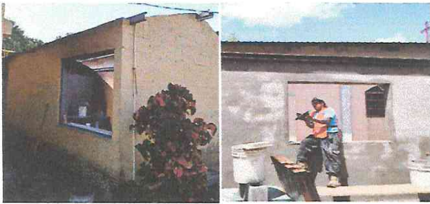
Foto 3: Sustitución de ventanas de madera por metal.
