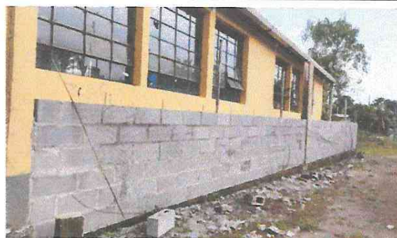
Foto 18: Levantado de muro perimetral.
