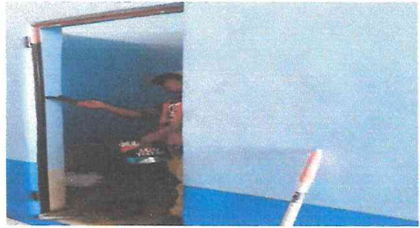
Foto 4: Pintura en muros exteriores e interiores en cocina.
