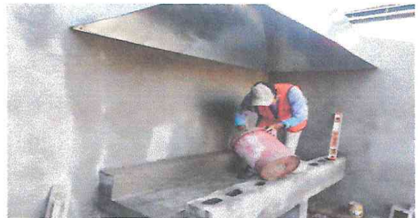
Foto 6: Sustitución de estufa rural (Completa chimenea).
