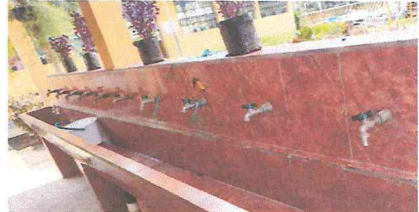
Foto 8: Sustitución de chorros.
