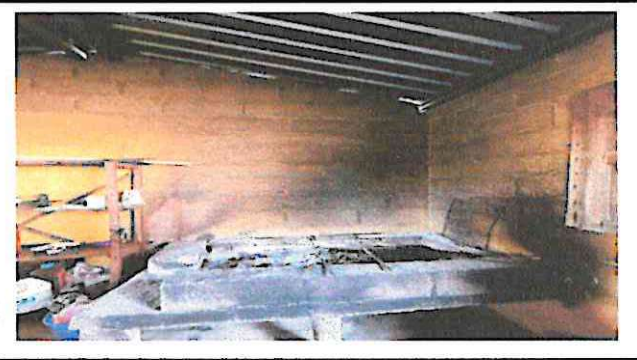
Foto 2: Sustitución de estufa rural incluirá chimenea.
