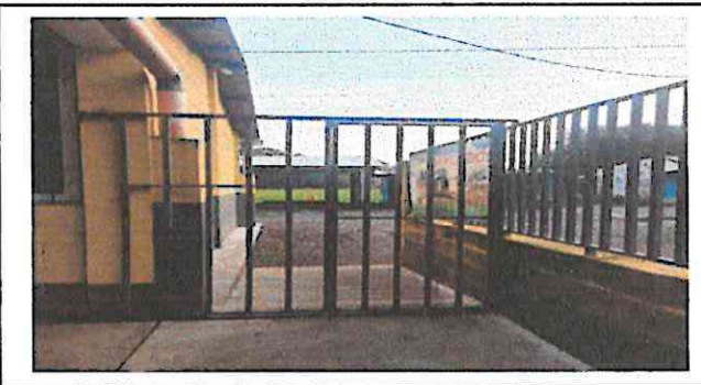
Foto 6: Sustitución de puerta de metal.
