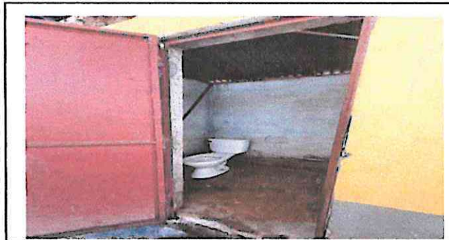
Foto 5: Sustitución de accesorios de inodoro, tapadera, mantenimiento puertas.
