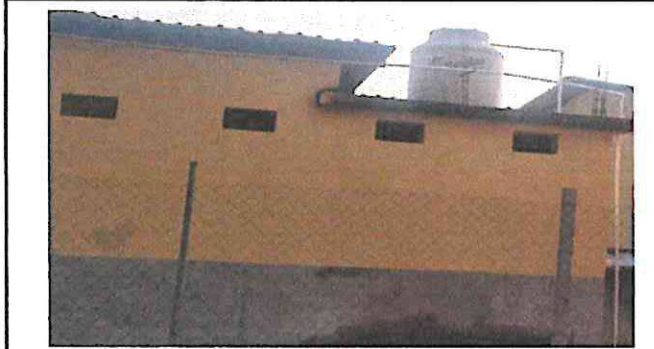
Foto 3: Sustitución de depósito de agua por uno de 1700 litros, Sustitución de llaves de chorro.
