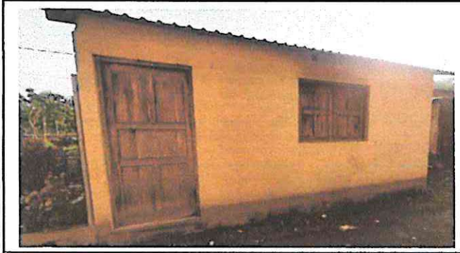
Foto 1: Sustitución de puerta y ventanas de madera por metal, repello, cernido y pintura en paredes, sustitución de torta de concreto por piso de azulejo, mantenimiento del techo y estructura de soporte de metal, instalación de azulejo en mueble de cocina.
