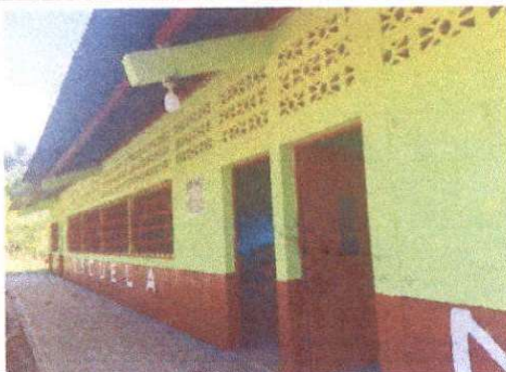
Foto 5: Pintura en muros exteriores e interiores.
