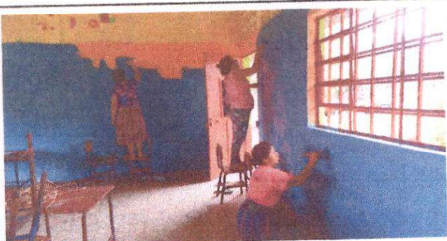
Foto 5: Pintura en muros exteriores e interiores.
