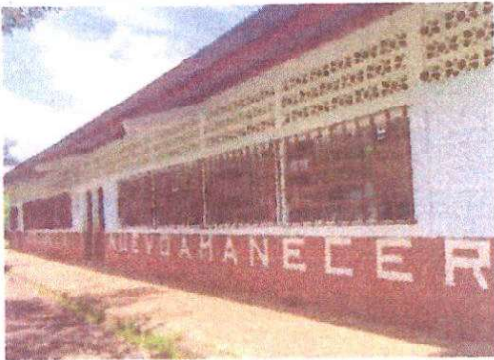
Foto 3: Sustitución de piso cerámico en corredor. Mantenimiento a balcones de metal de aulas. Mantenimiento a puertas de metal de aulas. Pintura en muros exteriores e interiores.
