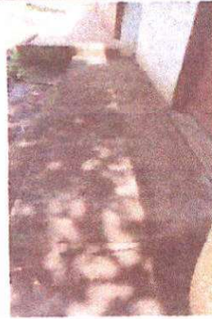
Foto 2: Reparación de banqueta de concreto de cocina.
