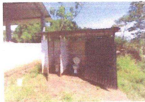
Foto 6: Sustitución de inodoros.
