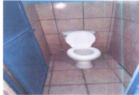
Foto 2: Sustitución de inodoros.
