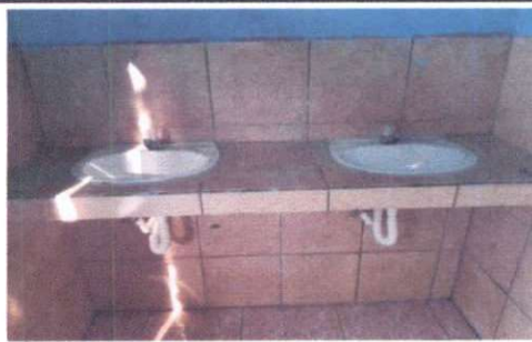
Foto 5: Sustitución de lavamanos.
