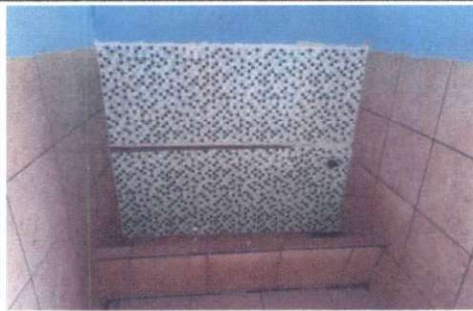
Foto 3: Reparación de mingitorio.
