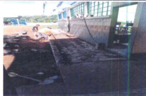
Foto 6: Sustitución de piso de granito por piso de patio en corredor de aulas. Sustitución de lámina y estructura de techo de aulas.
