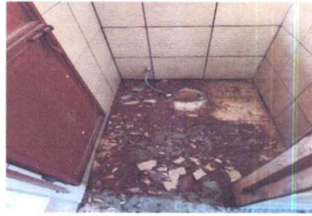
Foto 2: Sustitución de inodoros.
