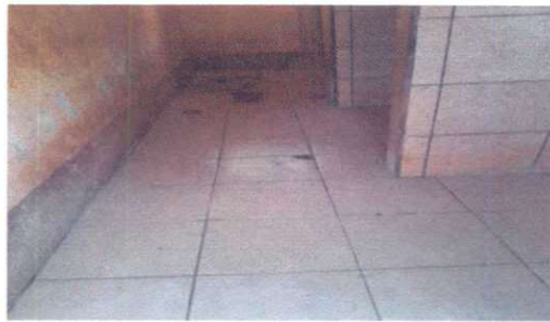
Foto 3: Reparación de mingitorio.
