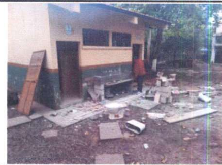
Foto 4: Suministro de lavamanos fijo de concreto de 1.75 x 0.45 en área exterior de sanitarios.
