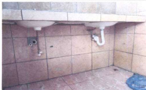
Foto 5: Sustitución de lavamanos.
