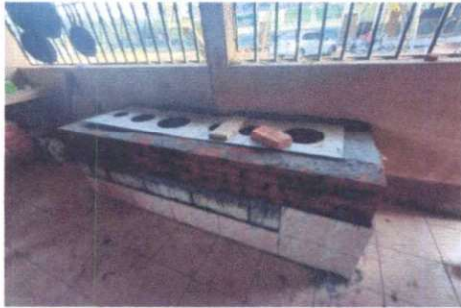
Foto 1: Suministro de estufa rural de 2 x 0.90 x 0.60 mts. Suministro de azulejo en parte inferior de mueble fijo de concreto. Suministro de puerta demetal para gabinete de cocina.
