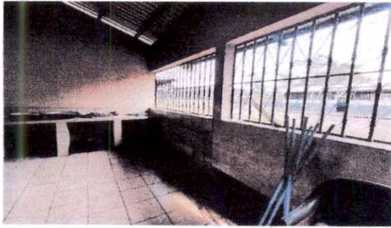
Foto 1: Suministro de estufa rural de 2 x 0.90 x 0.60 mts. Suministro de azulejo en parte inferior de mueble fijo de concreto . Suministro de puerta de metal para gabinete de cocina.
