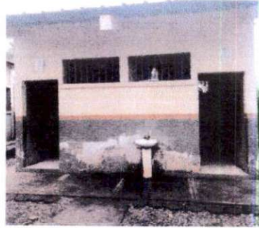
Foto 4: Suministro de lavamanos fijo de concreto de 1.75 x 0.45 en área exterior de sanitarios.
