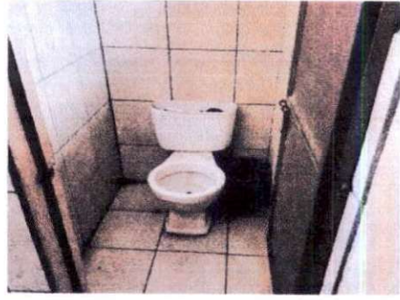
Foto 2: Sustitución de inodoros.
