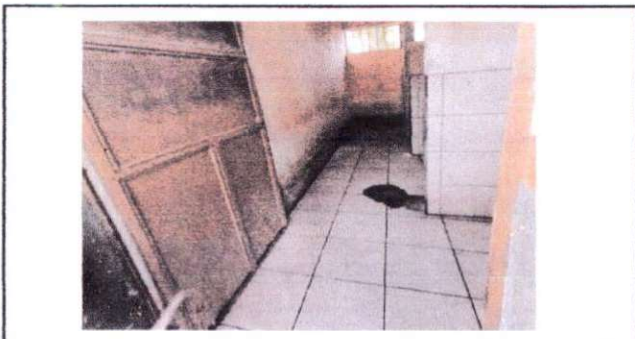
Foto 9: Sustitución de piso cerámico por piso cerámico en servicio sanitario. Sustitución de chapa y mantenimiento a puertas de metal de servicios sanitarios
