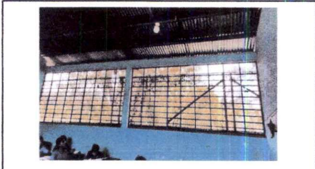
Foto 8: Suministro e instalación de block en muro de aulas.
