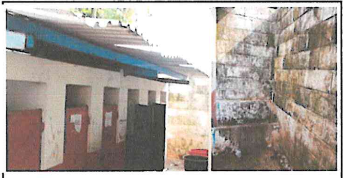
Foto 6: Techo faltante en Mingitorio y Mingitorio en deterioro.
