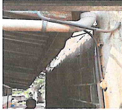
Foto 2: Canal de Caída de Agua de Lluvia en extensión de 4 aulas...
