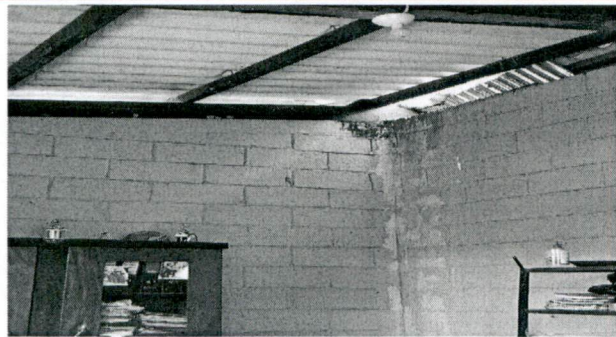
Sustitución de cubierta de lámina y estructura de techo en módulo de aulas, reparación de cableado eléctrico
