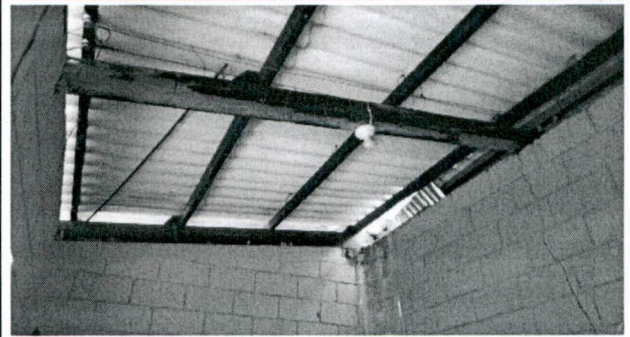
Sustitución de cubierta de lámina y estructura de techo en módulo de aulas, reparación de cableado eléctrico
