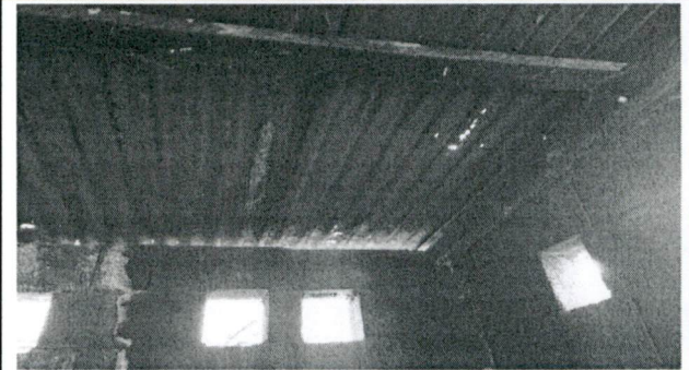
Sustitución de cubierta de lámina y estructura de techo en cocina, reparación de cableado eléctrico
