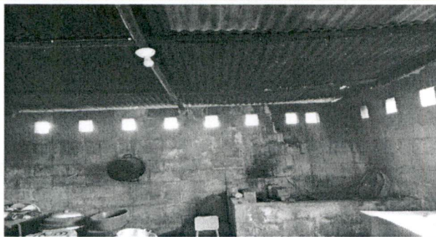
Sustitución de cubierta de lámina y estructura de techo en cocina, reparación de cableado eléctrico
