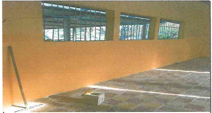
Foto 4: Reparación de pared con columnas y repello.
