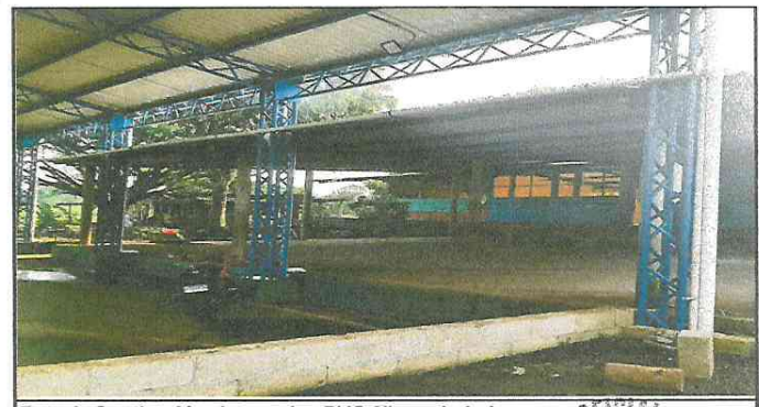
Foto 6: Sustitución de canales PVC 3" con bajada.
