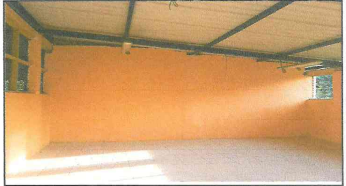
Foto 2: Reparación de piso de torta de concreto.
