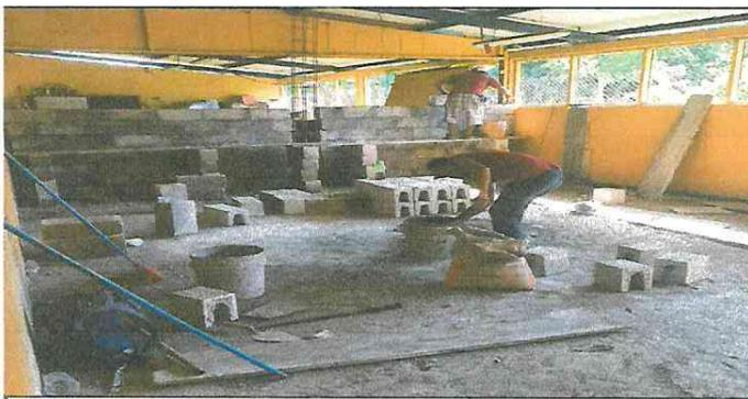
Foto 5: Reparación de pared con columnas y block.
