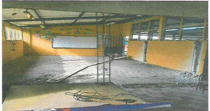
Foto 4: Reparación de pared con columnas y repello.
