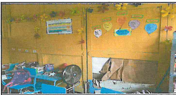
Foto 5: Reparación de pared con columnas y block.
