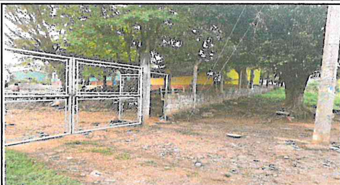
Foto 1: Reparación de muro perimetral de enfrente, mantenimiento de porton con lámina lisa, mantenimiento de puerta principal con lámina lisa.
