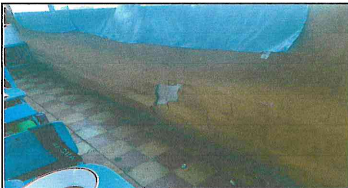
Foto 3: Repello de pared ambos lados del aula.
