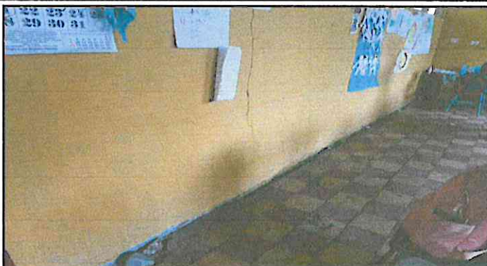
Foto 2: Reparación de piso de torta de concreto.
