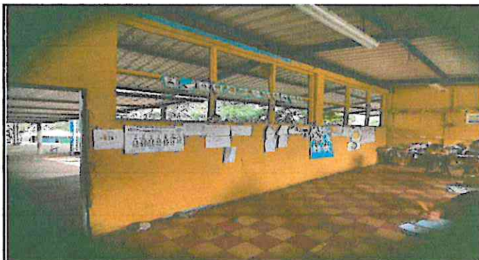
Foto 4: Reparación de pared con columnas y repello.
