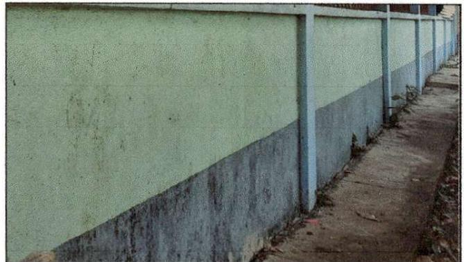
Foto 10: Estado actual de la pintura en muros del establecimiento, solicitan la aplicación de pintura debido al desgaste en el que se encuentra.
