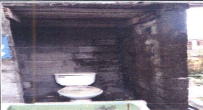
Foto 3: Sustitución inodoros (incluye accesorios)
