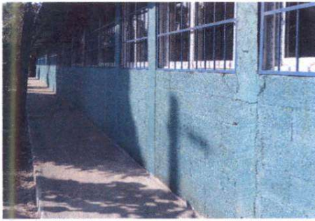
Foto3: Pintura en muros exteriores e interiores.
