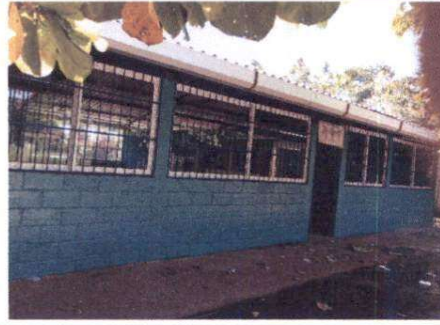
Foto2: Pintura en muros exteriores e interiores.
