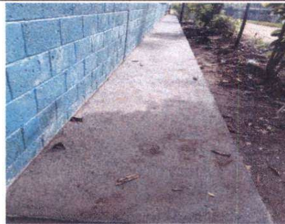
Foto4: Sustrucción mesa de concreto, por banqueta de concreto.
