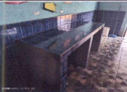
Foto5: Suministro de mesa de concreto fundido revestida de azulejos.
