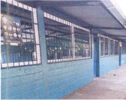
Foto1: Sustrucción de ventana, por ventana de pvc.
