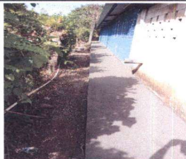
Foto6: Sustrucción mesa de concreto, por banqueta de concreto.
