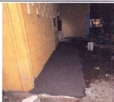
Foto 4: Sustrucción mesa de concreto, por banqueta de concreto.
