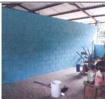
Foto 3: Pintura en muros exteriores e interiores.
