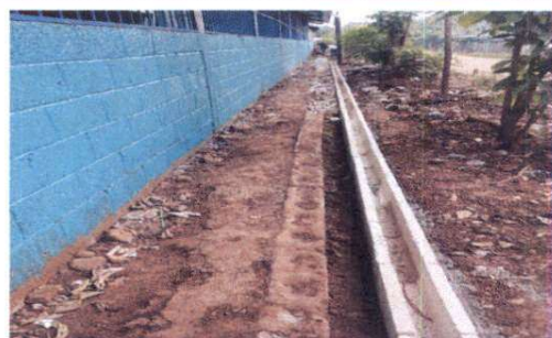
Foto 6: Sustrucción mesa de concreto, por banqueta de concreto.
