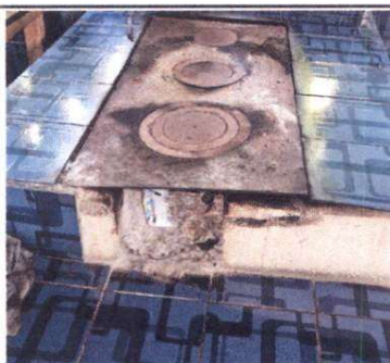
Foto 3: Sustitución de plancha de estufa rural dañada por plancha de estufa
