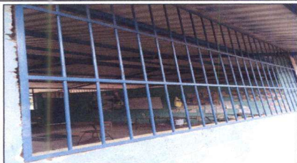
Foto1: Instalación de ventanas de pvc
