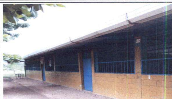
Foto2: Sustitución de pintura vieja por pintura nueva.
