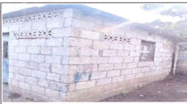
Foto 5: Repello en muro modulo uno
