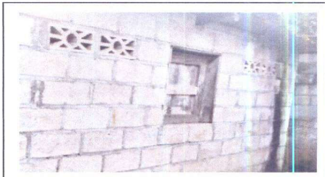
Foto 4: Sustitución de ventana de madera, por balcones de metal.
