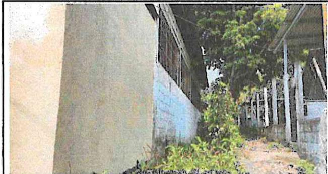
Foto 2: Cernido de muro posterior, por cuanto que se tiene el block normal y se está deteriorando.
