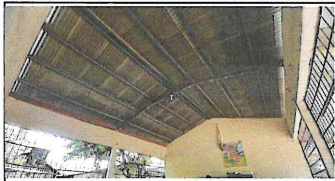
Foto 2: Sustitución de cubierta de lámina troquelada Aluzinc por deterioro.
