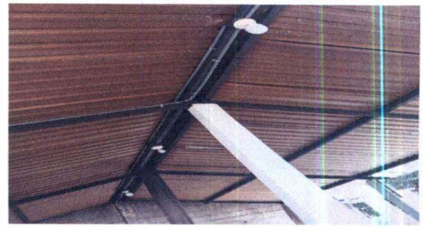
Foto 2: Sustrucción de sistema eléctrico.
