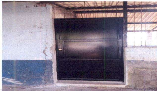
Foto 1: Sustrucción de puerta de metal.
