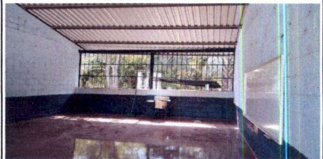
Foto 4: Sustitución de balcon metal.
