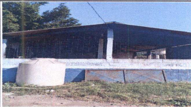
Foto 3: Sustrucción de maya en cocina, por electromalla.
