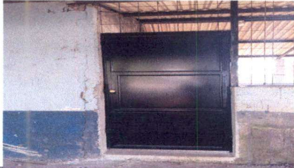
Foto 1: Sustitución de puerta de metal.
