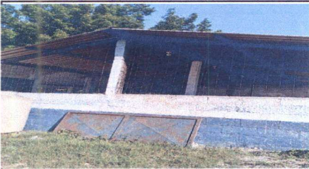
Foto 3: Sustitución de maya en cocina, por electromalla.
