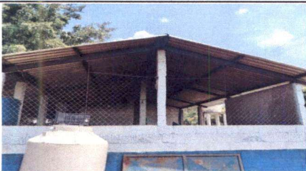
Foto 3: Sustrucción de maya en cocina, por balcon.
