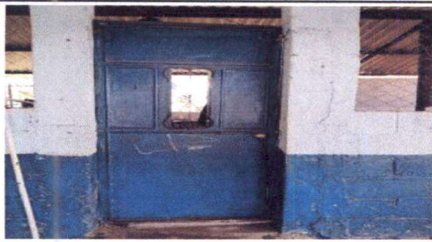
Foto 1: Sustrucción de puerta de metal.
