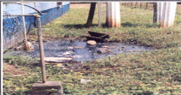
Foto 5: Sustitución de drenaje de agua negra.
