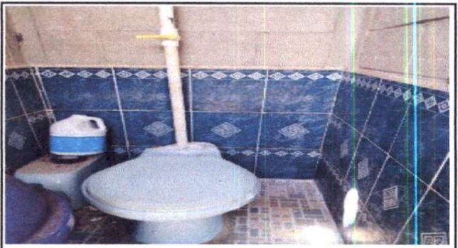
Foto 4: Reparación de tasas de baños
