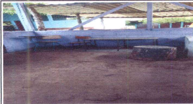
Foto 3: Sustrucción de torta de concreto, por piso cerámico.
