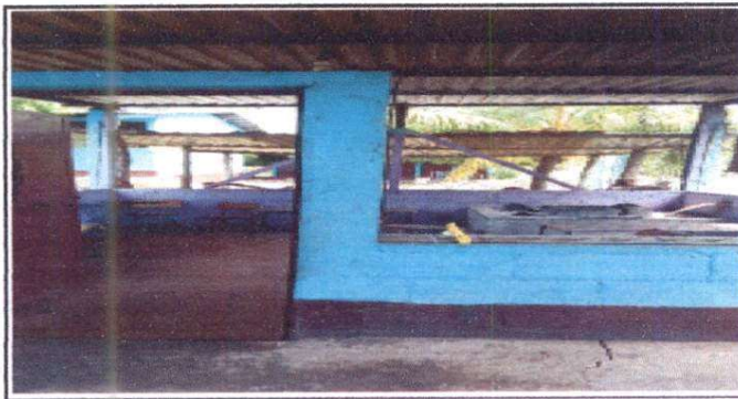
Foto 5: Relleno en cocina para nivelar.
