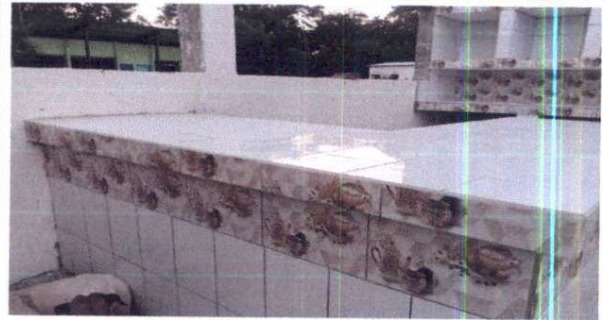
Foto 2: mesa de concreto en cocina terminado
