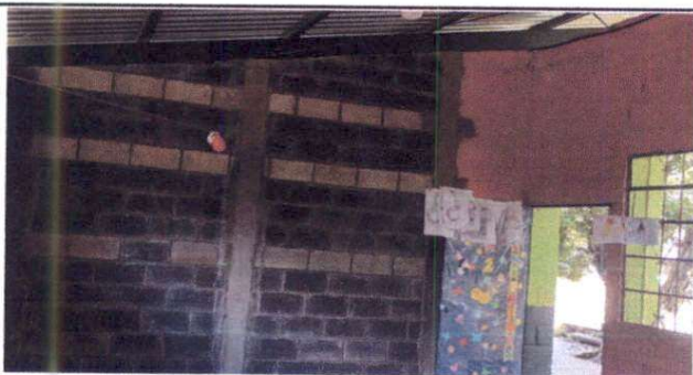
Foto 5: pared del aula dos terminado
