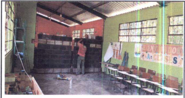
Foto 2: albañiles en la construcción de la pared del aula uno
