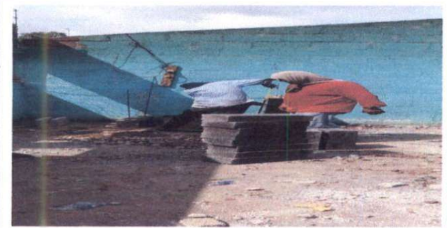
Foto 5: albañiles destruyendo polleton en mal estado
