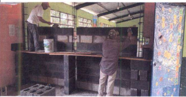
Foto 3: albañiles trabajando en la construcción de la pared del aula dos
