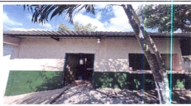
Foto 6: Apicación de pintura en muros interiores y exteriores
