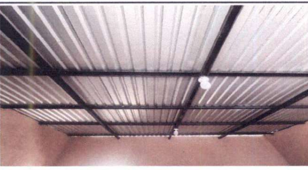
Foto 5: Sustitución de cubierta de lámina por lámina troquelada calibre 26
