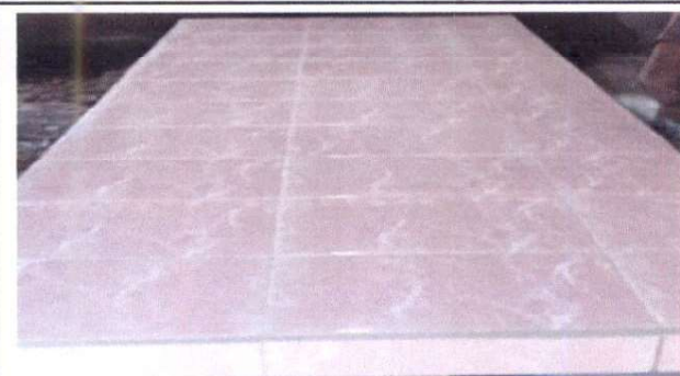
Foto 3: Sustitución de azulejo en mesa de trabajo de concreto
