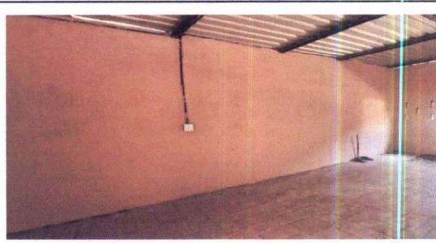
Foto 2: Sustitución de repello y cernido en paredes
