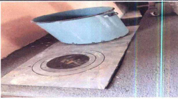
Foto 4: Sustitución de estufa rural completa
