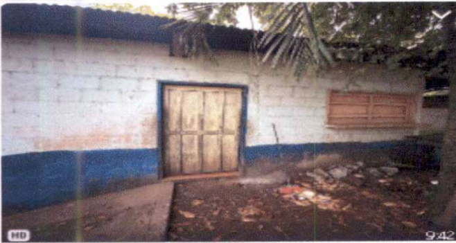
Foto 1: Reparación de área de cocina
