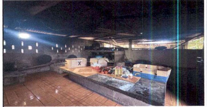
Foto 2: Reparación de área de cocina
