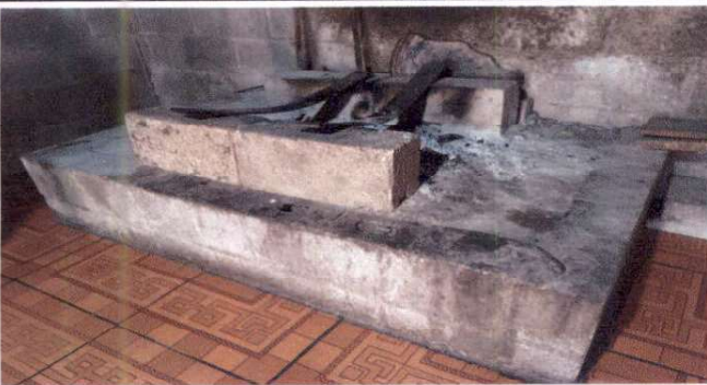
Foto 3: Sustitución de estufa rural completa
