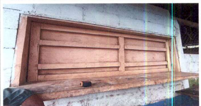
Foto 4: Sustitución de ventana de madera por ventana de metal abatible hacia arriba
