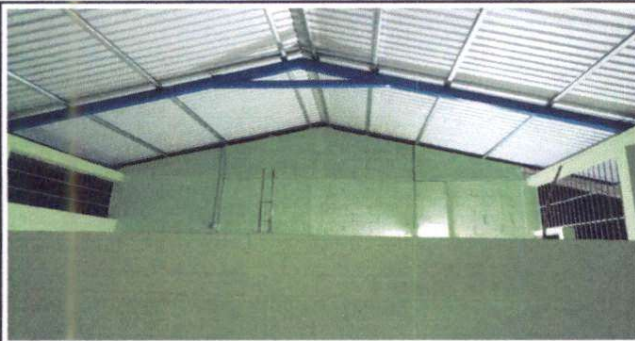
Foto 3: Sustitución de lámina por lámina troquelada azulinc calibre 26
