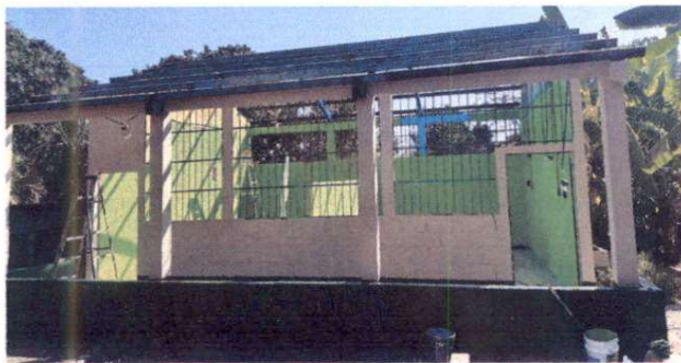
Foto1: Sustitución de pintura en muros exteriores e interiores
