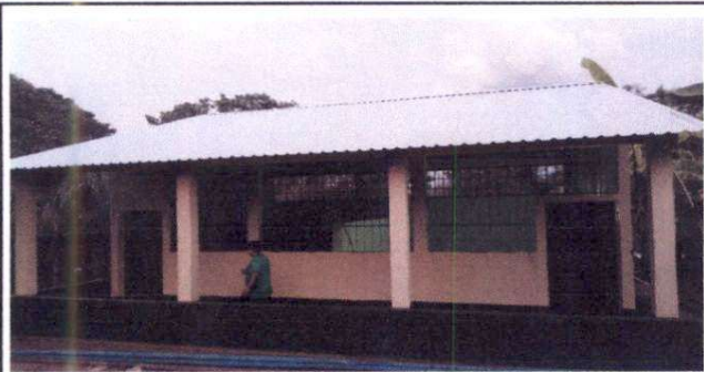
Foto 5: Sustitución de puertas de metal por metal de 2.20 x 1 mt
