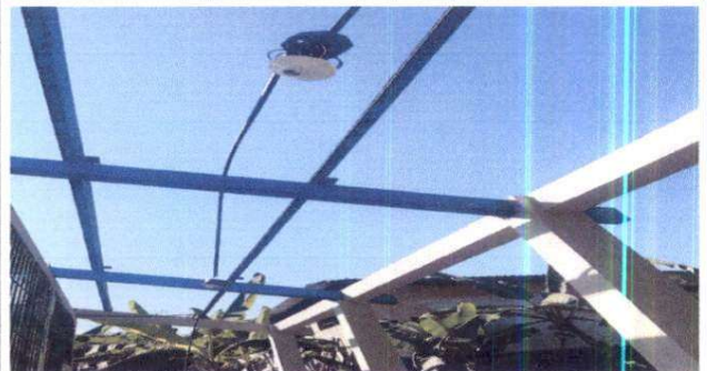
Foto 4: Sustitución de focos LED y reparación de sistema eléctrico
