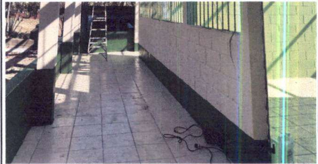
Foto 2: Sustitución de piso de concreto por piso cerámico en aulas y corredor
