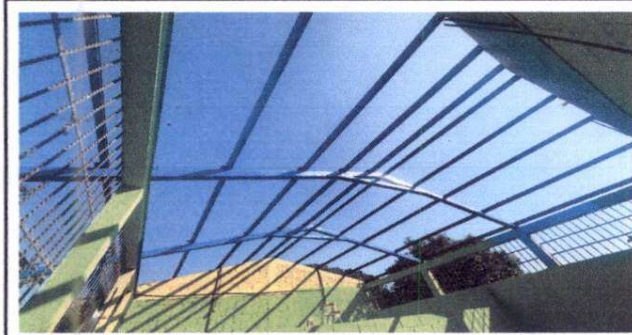
Foto 3: Sustitución de lámina por lámina calibre 26
