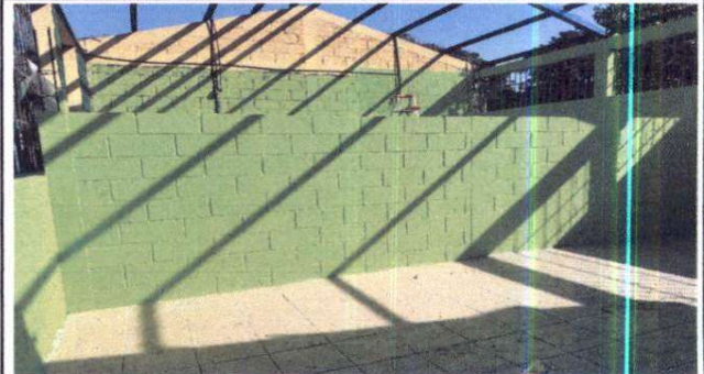
Foto 2: Pintura en muros interiores y exteriores
