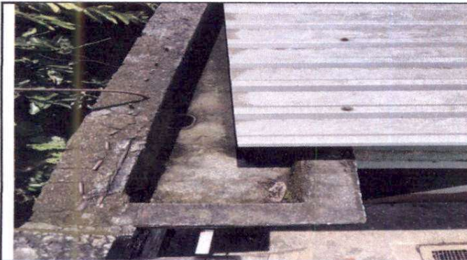
Foto 3: Sustitución de canal de concreto por metal
