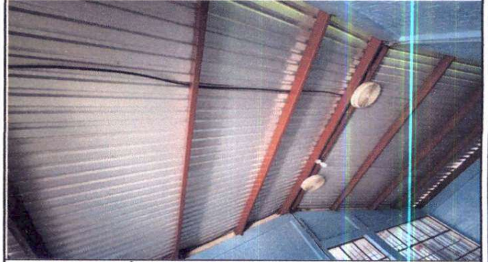
Foto 2: SUSTITUCIÓN DE LAMPARAS
