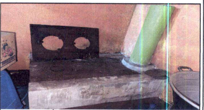
Foto 6: SUSTITUCIÓN DE CHIMENEA DE CONCRETO
