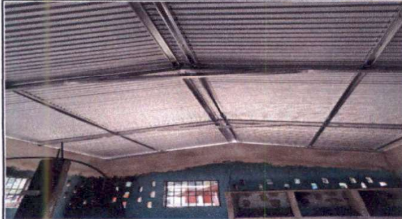
Foto1: Sustitución de lámina, por lámina troquelada aluzinc caibre 26 Sustitución de estructura de soporte de metal, por metal
