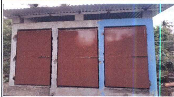
Foto 2: Mantenimiento a estructura, sustitución de puertas de metal por metal.
