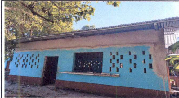
FOTO 5: Sustitución de lámina, por lámina troquelada aluzinc caibre 26 Sustitución de estructura de soporte de madera, por metal
