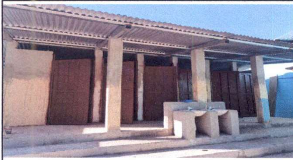
Foto 3: Pintado de puerta del servicios sanitarios 1.88 X 89 Incluye mano de obra
