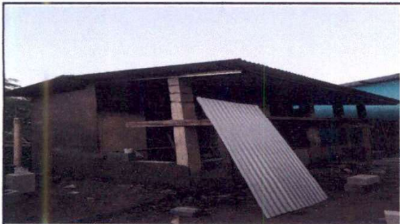
Foto 3: Sustitución de puerta del servicios sanitarios 1.88 X 89 Incluye mano de obra
