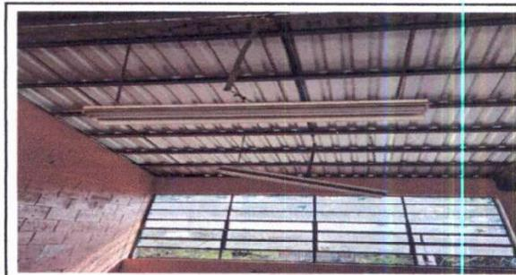
**Foto 6:** Sustitución de sistema eléctrico, (incluye interruptor, ducto, cable, tomacorriente 12, plafoneran15, bombilla 15, apagador doble 5, apagadora unitario 5, caja octagonal 15, caja rectangular 15 en modulo
