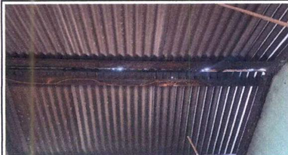
**Foto 1:** Sustitución de lámina, por lámina troquelada aluzinc caibre 26
