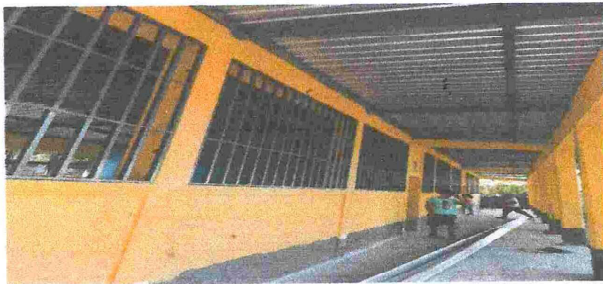
Foto 5: Sustitución de balcones en modulo V
