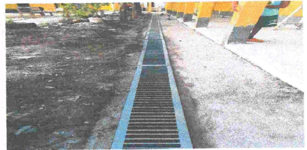
Foto 4: Reparación de cuneta de concreto en modulo IV
