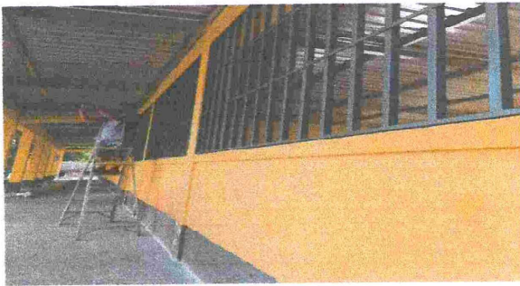
Foto 3: Reparación de banqueta de concreto en modulo IV
