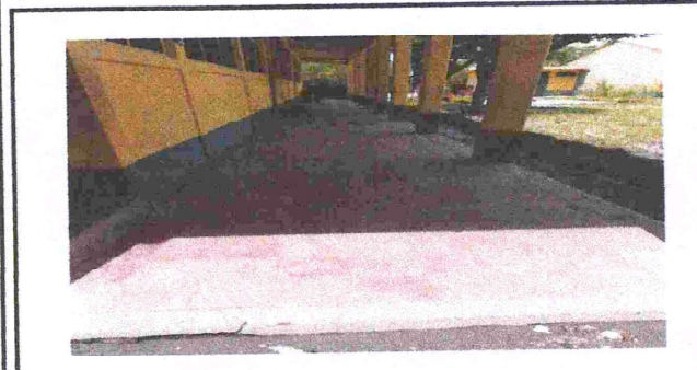
Foto 3: Reparación de banqueta de concreto en modulo IV
