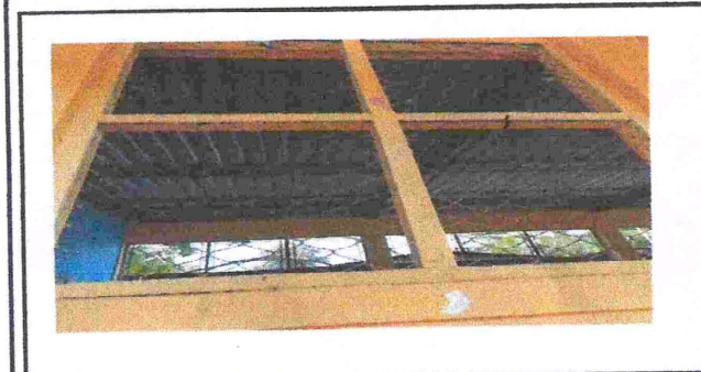
Foto 5: Sustrucción de balcones en modulo V
