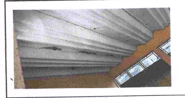
Foto 6: Sustrucción de techo en modulo II
