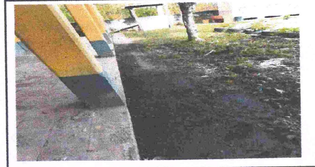
Foto 4: Reparación de cuneta de concreto en modulo IV
