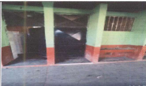
Foto 5: Sustitución de piso de cemento, por piso cerámico antideslizante.
