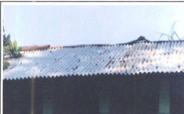
Foto 3: Sustitución de lámina, por lámina troquelada aluzinc caibre 26
