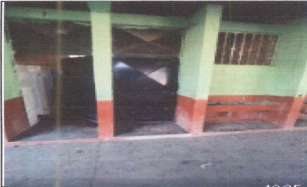
Foto1: Mantenimiento a estructura (lijado, cambio de tubo, cepillado, aplicado de pintura)
