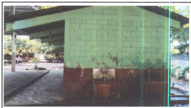
Foto 6: Instalación de sistema eléctrico (incluye, ducto, cable, cajas rectalgulare, fliponeras) y chorros con pileta para lavarse las manos.
