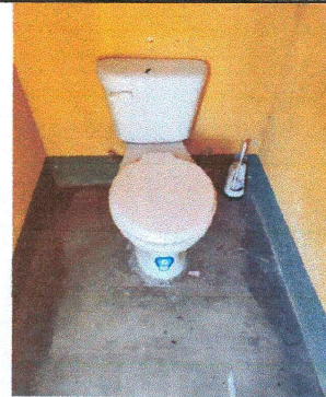
Foto 4: CAMBIO DE 6 INODOROS
