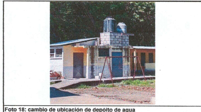
Foto 18: cambio de ubicación de depósito de agua
