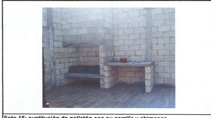
Foto 15: sustitución de polletón con su parrilla y chimenea
