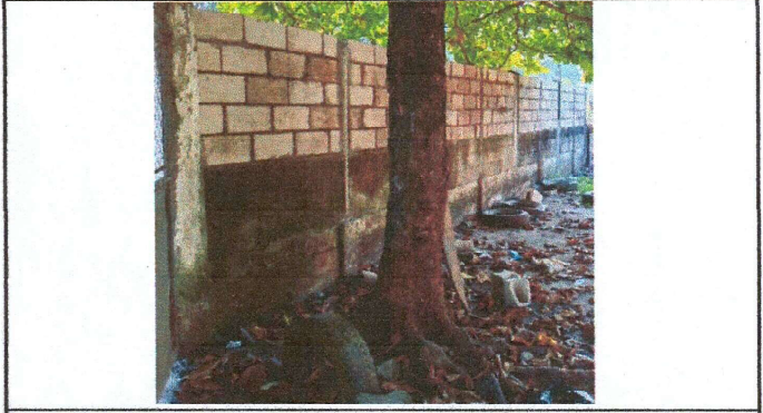
Foto 8: CAMBIO DE MALLA POR BLOCK EN PERÍMETRO DE LA CALLE EN MURO PERIMETRAL
