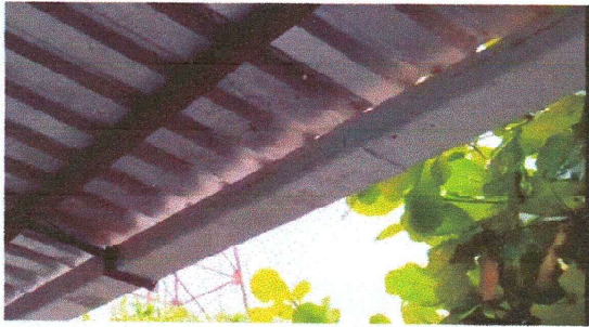
Foto 3: sustitución de canal de agua pluvial en galera
