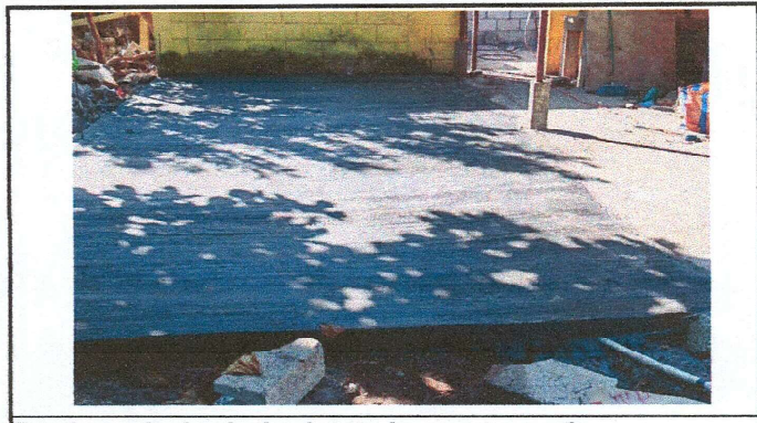
Foto 14: sustitución de piso de torta de concreto en patio
