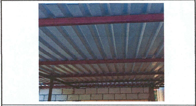
Foto 7: CAMBIO DE LAMINA Y COLUMNAS DE GALERA EN PATIO
