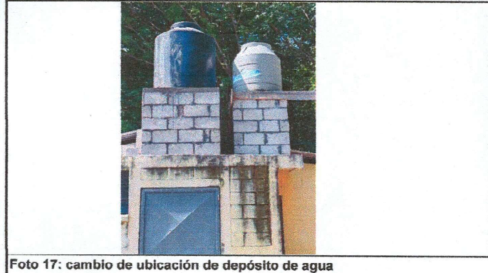
Foto 17: cambio de ubicación de depósito de agua
