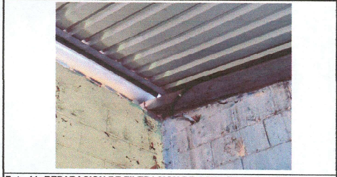
Foto 11: REPARACION DE FILTRACION DE AGUA EN LA PARED
