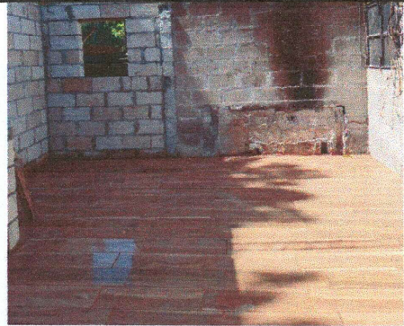
Foto 2: cambio de torta de piso por piso cerámico en cocina
