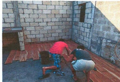
Foto 2: cambio de torta de piso por piso cerámico en cocina
