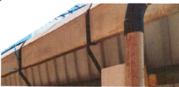
Foto 3: sustitución de canal de agua pluvial en galera
