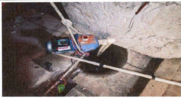
Foto 1: CAMBIO DE BOMBA DE AGUA, POR UNA SUMERGIBLE
