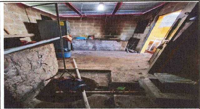
Foto 2: cambio de torta de piso por piso cerámico en cocina
