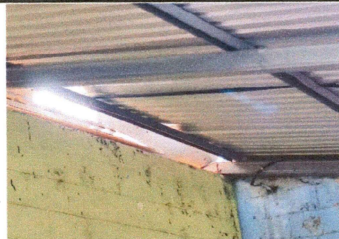
Foto 10: REPARACION DE CAPOTE Y REPARACION DE LÁMINAS DAÑADAS
