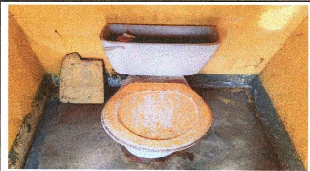
Foto 4: CAMBIO DE 6 INODOROS
