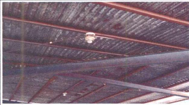
Foto1: Sustitución de cubierta de lámina por lámina acanalada calibre 26
