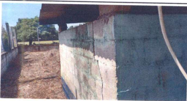
Foto 5: Reparación de área de cocina
