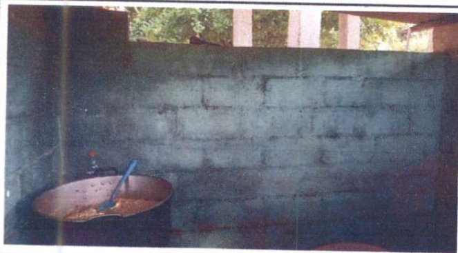
Foto 3: Reparación de área de cocina
