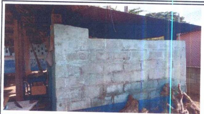
Foto 2: Reparación de área de cocina
