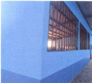
Foto 3: Sustitución de pintura en muro de las aulas tanto interno como externo
