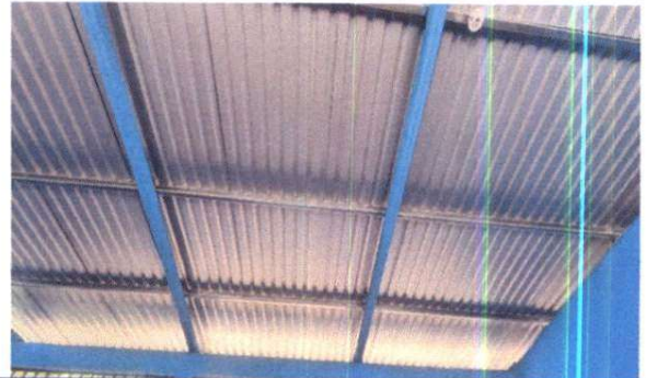
Foto 2: Sustitución de estructura de metal, por metal
